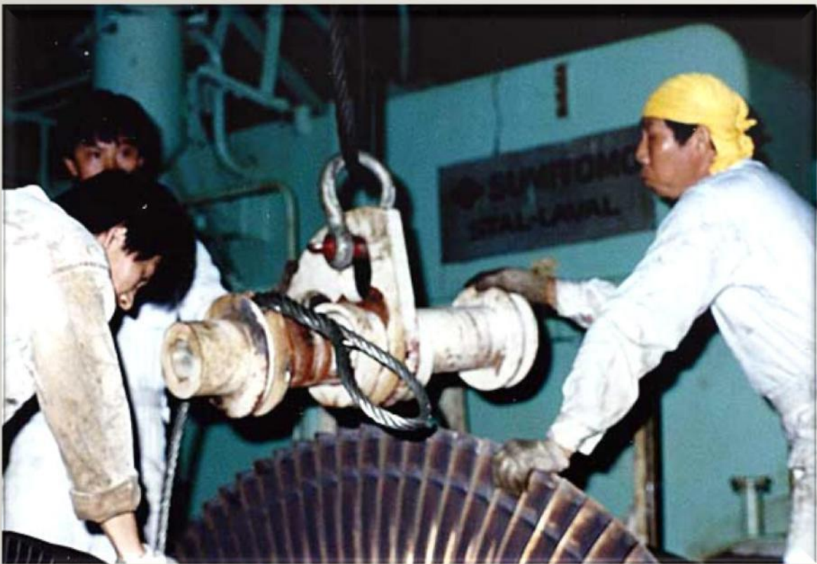
Förberedelser för lyft av LP rotorn
