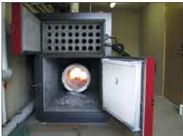
La grande porte de la chaudière permet d'accéder facilement pour le contrôle de la chaudière/du brûleur. La porte supérieure permet d'accéder au refroidisseur de fumée de la chaudière où le gaz de fumée est refroidi.
