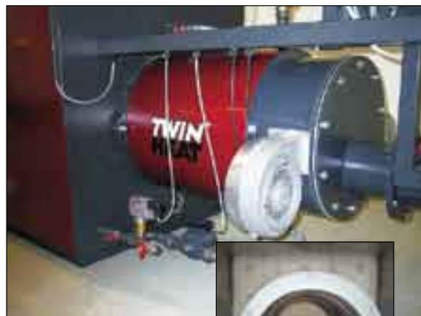
Le biocombustible est brûlé dans le brûleur à refroidissement à l'eau. L'air de combustion est préchauffé dans le brûleur à env. 300 à 400°C
