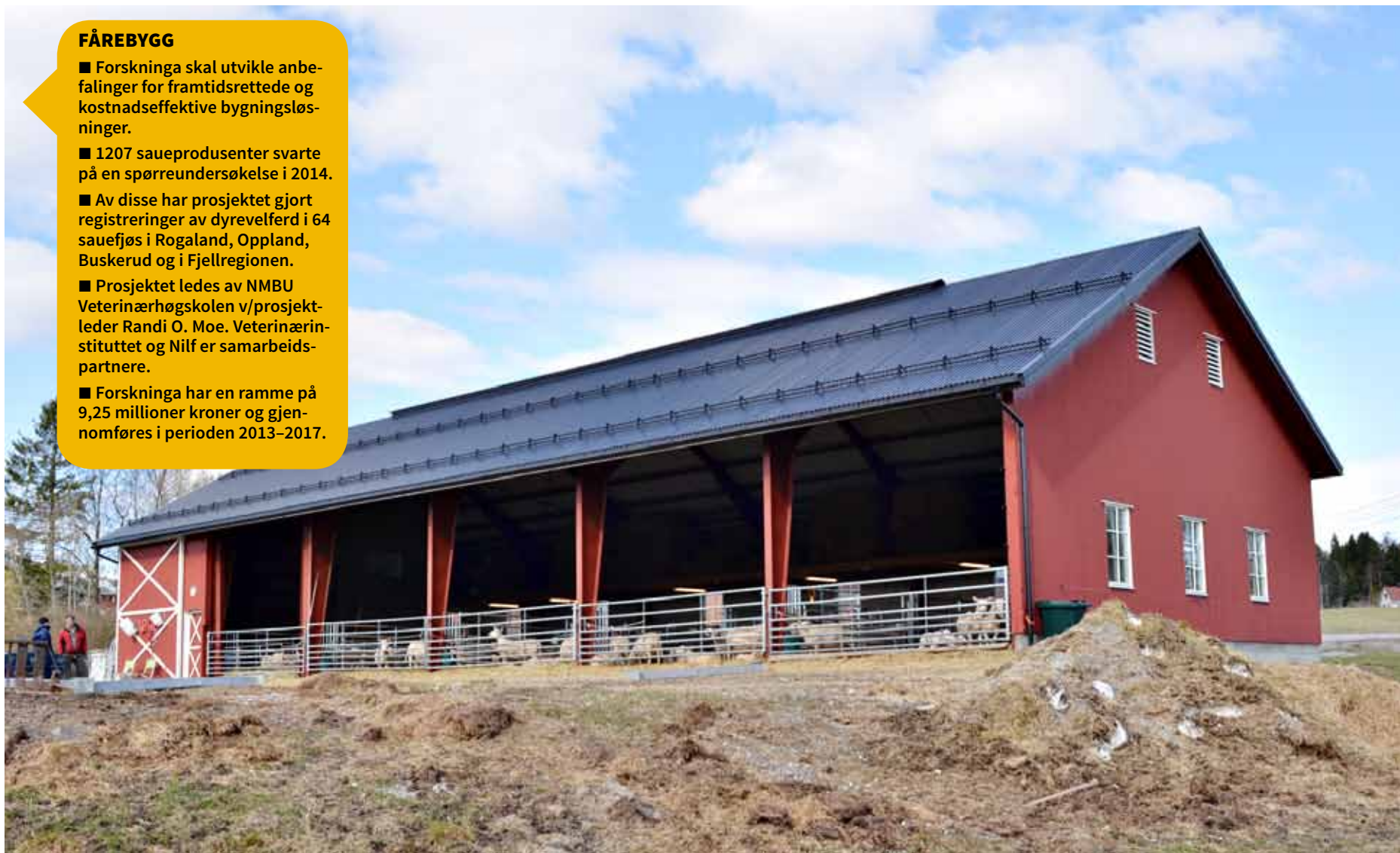
Uten vegg: Et åpent kaldfjøs med tre vegger til 1,6 millioner kroner ble løsninga da sauebonde Anders Baumann bygget ny driftsbygning.
