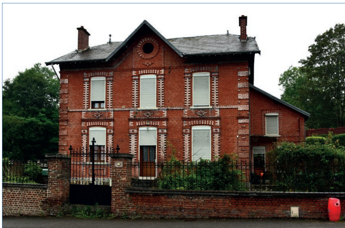
Les bureaux des ardoisières La Renaissance et Saint-Joseph, rue des Évignes à Fumay. Photo P. Cattelain, Écomusée du Viroin, juillet 2017.
