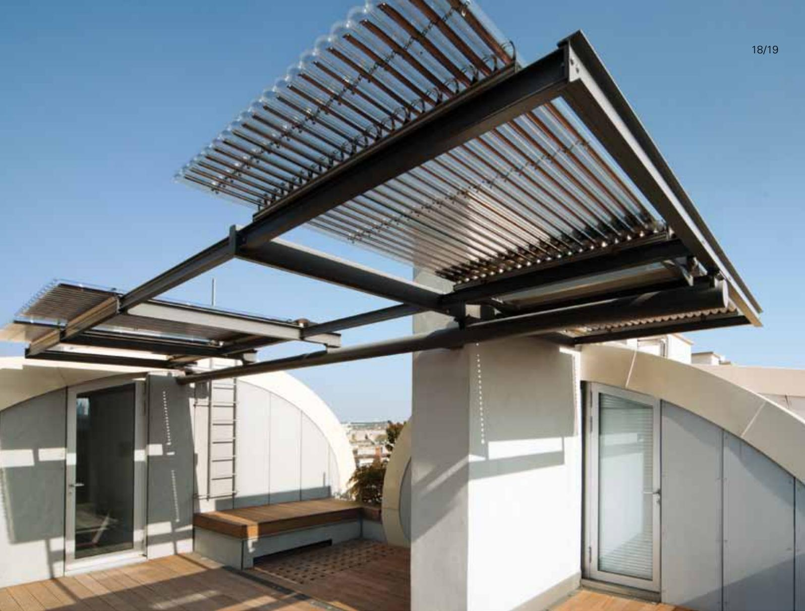
Beispiel für den Einsatz von Vitosol 200-T Röhrenkollektoren
