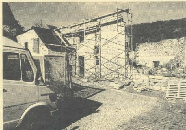
Les travaux de consolidation des ruines de la grange en cours de réalisation.
