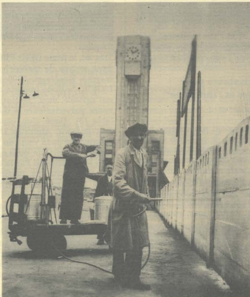
Chaulage des murs avec un pulvérisateur DEKLERCK à la Jonction Nord-Midi à Bruxelles.Midi, à Bruxelles
