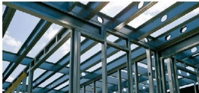
L'habillage intérieur des murs et des planchers est réalisé en plaques de plâtre BA13 vissées directement dans l'ossature LSF **réglée au laser au montage et respectant donc les tolérances de planéité** . De plus l'alliage des profils LSF n'étant **pas soumis aux dilatations thermiques** , le risque de fissuration du revêtement placo est nul.
