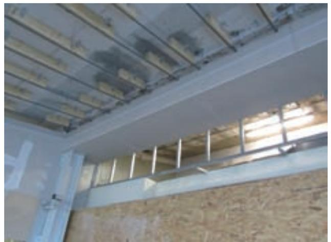
Stahlseile unter neuer Wärmedämmschicht
