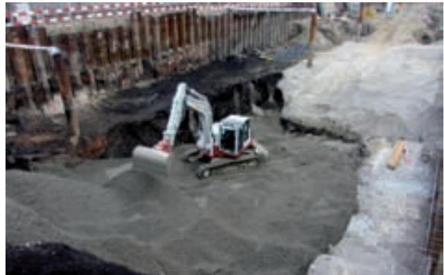
Bodenaustausch im Bereich kontaminierte Schlacke
