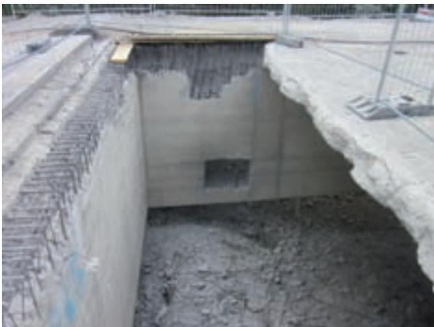
Abtragsarbeiten, Vorbereitung Vorspannungsmaßnahmen, P44 Widerlager Graz
