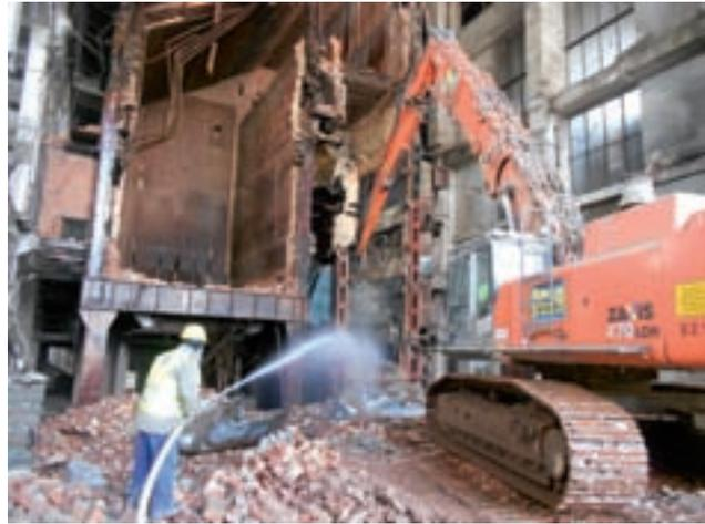
Bild 4: Kesseldemontage innerhalb der Gebäudehülle
