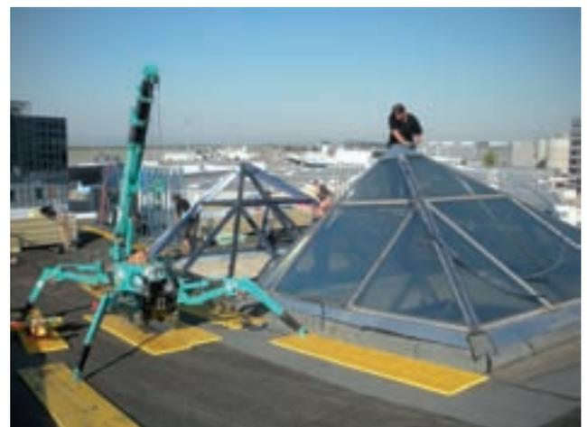
Abbruch der Glaspysramiden mithilfe eines Mini-Rampenkrans
