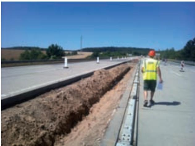
Sanierung des mittleren Trennstreifens, Auswechslung sämtlicher Kabelleitungen und Sanierung der mittleren Entwässerungsleitung
