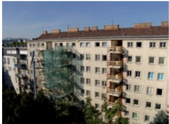
Umgesetzter Treppenturm nach Rohbau des Nachbarstiegenhauses
