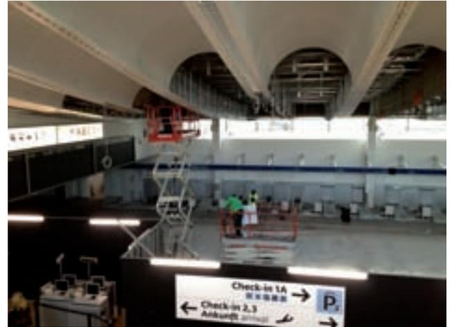
Demontage der bestehenden Decke mithilfe von Scherenarbeitsbühnen
