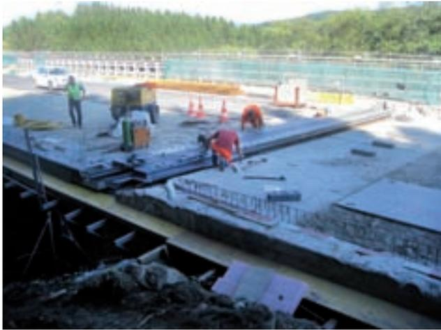
P44 WDL Graz, Einbau Fahrbahnübergangskonstruktion
