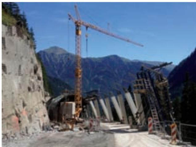
Beginn der Blockherstellung mittels Schalwagen
