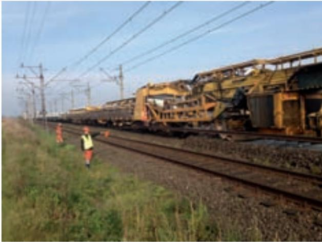
Schwellenaustausch auf der Linie 351 mit Hilfe des Umbauzugs Matisa P93
