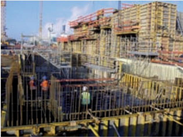
Kondensatgrube mit Turbinenfundament und Turbinentisch
