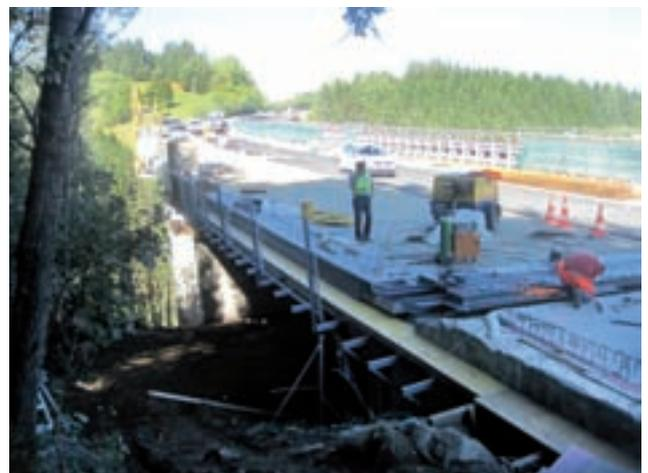
P44 WDL Graz, Einbau Fahrbahnübergangskonstruktion
