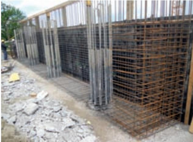
Bauwerkswiderlagerscheibe mit Einbindung in Bohrpfahl
