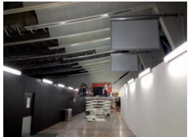
Demontage der bestehenden Decke in Nachtarbeit (links: Staubschutzwand Bauabschnitt 1, rechts: Staubschutzwand Bauabschnitt 2)
