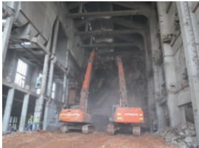
Bild 5: Kesseldemontage innerhalb der Gebäudehülle
