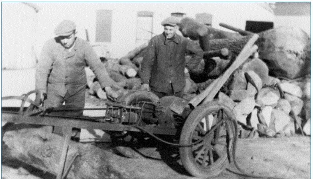
Tronçonneuse artisanale de Paul BOURTEMBOURG. Sur la photo avec la tronçonneuse, c'est un ouvrier qui travaillait ici, c'est malheureux elle a tourné en mitraille, on a tout jeté, ça valait des sous. C'était l'essieu avant d'une vieille Ford et on a coupé et on a foré des trous. Du moment que ça tenait c'était bon, avant c'était des roues de charrues de Brabant, mais un petit morceau de bois et on était calé avec ça, mais avec ceci ça montait dessus.
