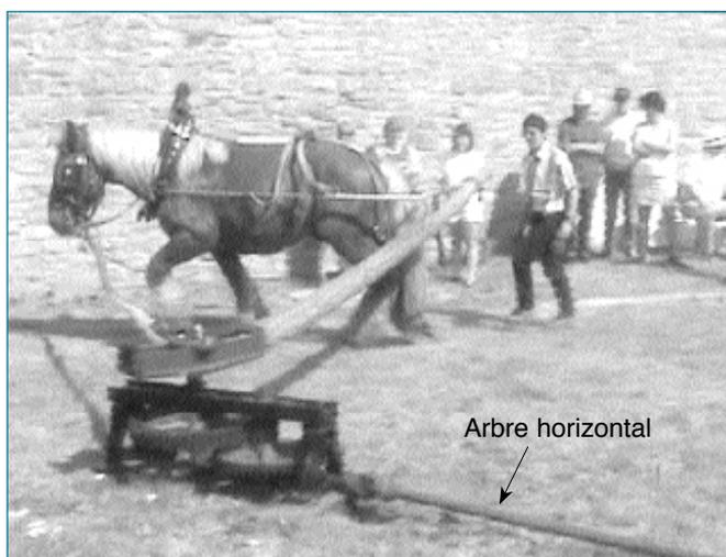
Comme cet arbre ne fait qu'en moyenne trois tours par minute, des engrenages multiplicateurs augmentent la vitesse pour l'amener à environ une vingtaine de tours. La machine, qui est commandée par le manège et placée en dehors de la piste suivie par le cheval, reçoit son mouvement par l'intermédiaire d'un arbre horizontal. Lorsque cet arbre se trouve au niveau du sol ou dans un caniveau établi à la surface du sol (*l'animal ne se cogne pas*), le manège est dit à terre.
