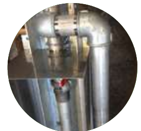
Piquage latéral Raccordement mélangeur
