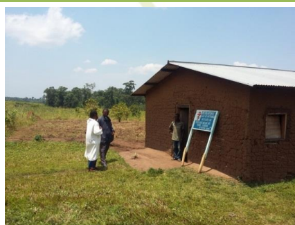
Antiguo centro de salud de Lume (construido con adobe)
