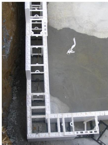
Cette structure est reliée à une dalle de béton à double paillasse de 25cm d'épaisseur assurant ainsi une stabilité optimale à l'ensemble de votre bassin.
