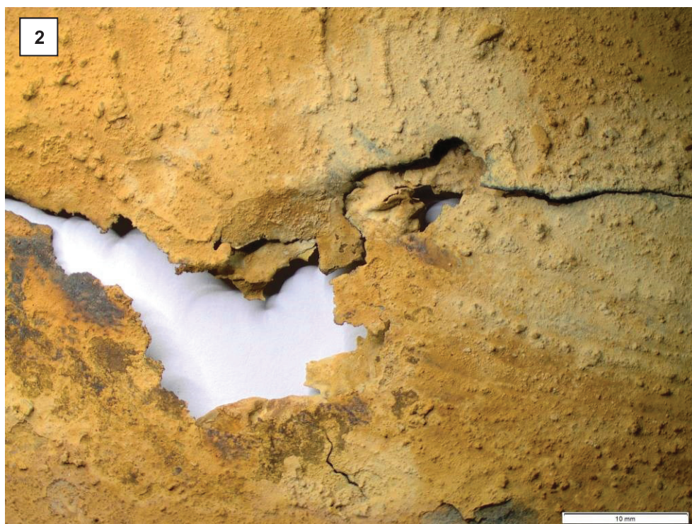
Figuur 12. Aan de randen van het lek was de wanddikte zeer gering. De lekranden bogen over het algemeen naar buiten en ter plaatse van de scheurvormige uitlopers iets naar binnen.
