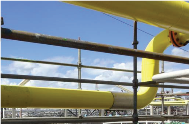
Afbeelding 3: aangebrachte brandweerklem
