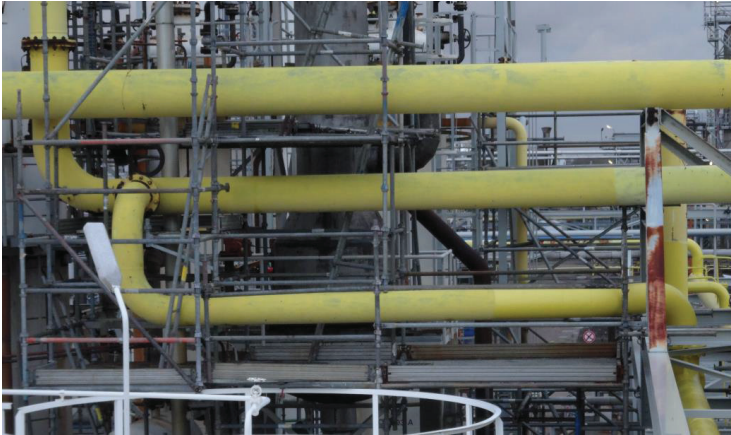
Afbeelding 5: Negatieve slope leiding LF943
