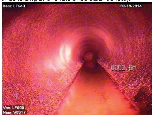
Afbeelding 4: water in leiding LF943
