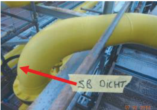
Afbeelding 6: Brilflens in dichte stand (foto) en brilflens in open stand (schematische weergave)
