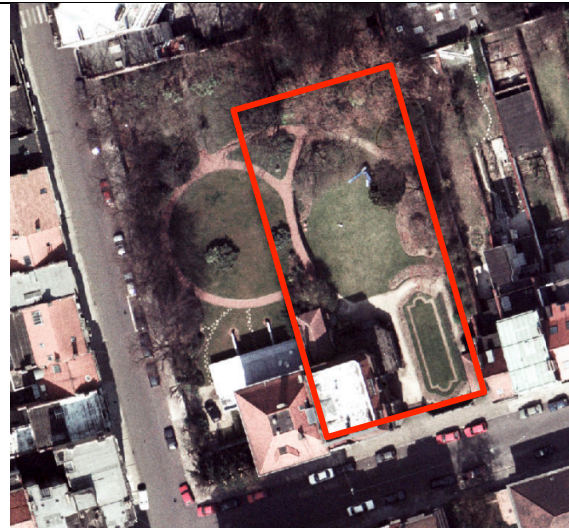
(Vue 1996©Bruciel) Jardin avec délimitation en rouge de la partie classée en 2016, révélant l'incohérence du classement partiel du jardin, qui fait perdre tout son sens au tracé d'origine et au même titre à la partie classée.
