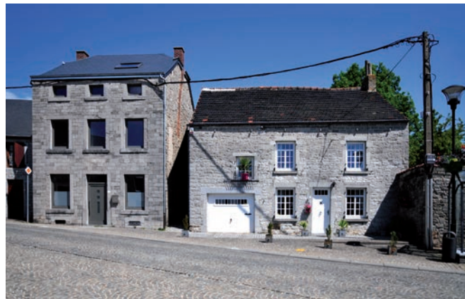
À droite, la maison des filles Hénin, sur la place de Treignes, où le général de Gaulle a logé en 1914. Photo P. Cattelain @ Écomusée du Viroin.
