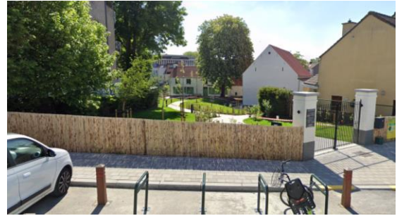
Exemple de palissade en châtaignier, construction sur mesure, projet Auberge des Maîtres à Woluwé-Saint-Pierre, projet Eole.
