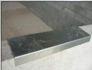
Coiffe métallique obligatoire pour clavetage des éléments préfabriqués Vstock.
