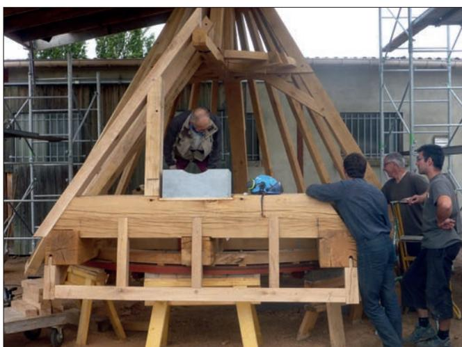
Fig. 33. Assemblage des éléments de la charpente. Photo © F. Platbrood.
