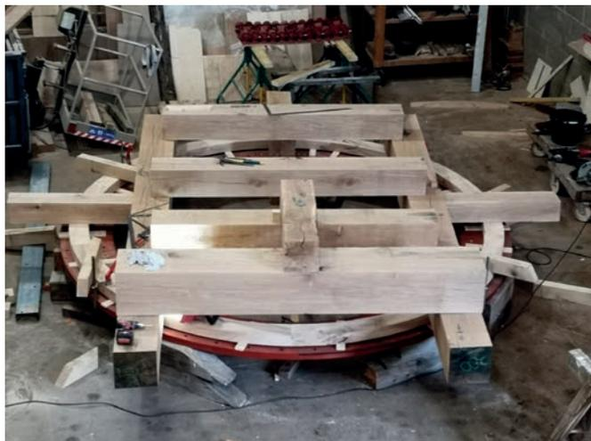
Fig. 32. Assemblage de la base de la coiffe dans les ateliers à Troyes. Photo © F. Platbrood.
