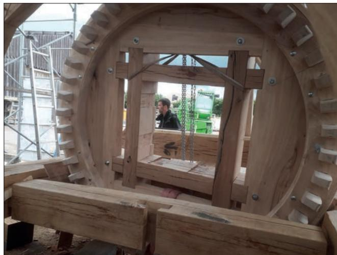
Fig. 60. Le rouet, avant sa mise en place sous la coiffe.
