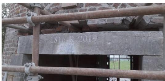
Fig. 25. Remplacement du linteau gravé. Photo © F. Platbrood.
