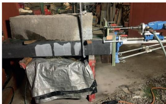
Fig. 24. Réparation du linteau en atelier. Photo © F. Platbrood.
