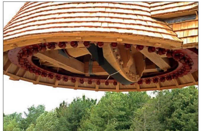
Fig. 39. La coiffe vue de dessous, en cours de placement.
