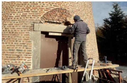
Fig. 23. Enlèvement du linteau. Photo © F. Platbrood.
