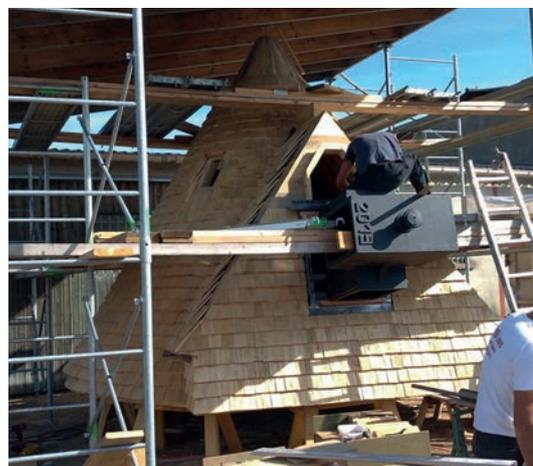
Fig. 35. Extrémité de l'arbre en acier. Photo © F. Platbrood.
