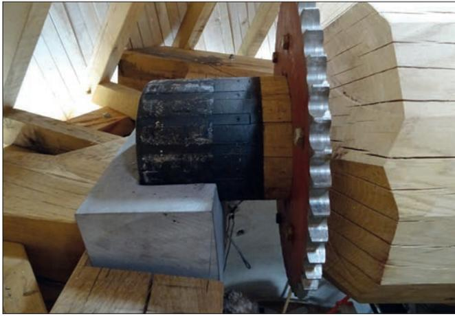
Fig. 36. Butée et roulement en deux pièces, en pierre bleue.
