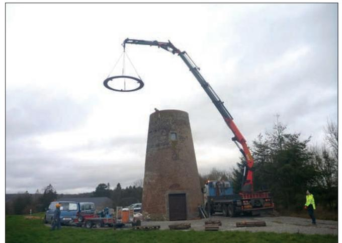
Fig. 30. Placement du chemin de roulement à l'aide d'un bras télescopique. Photo © F. Platbrood.
