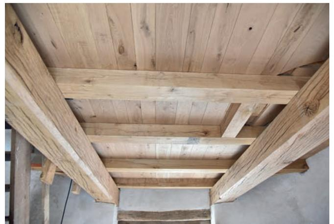
Fig. 57. Les planchers et leur structure portante.
