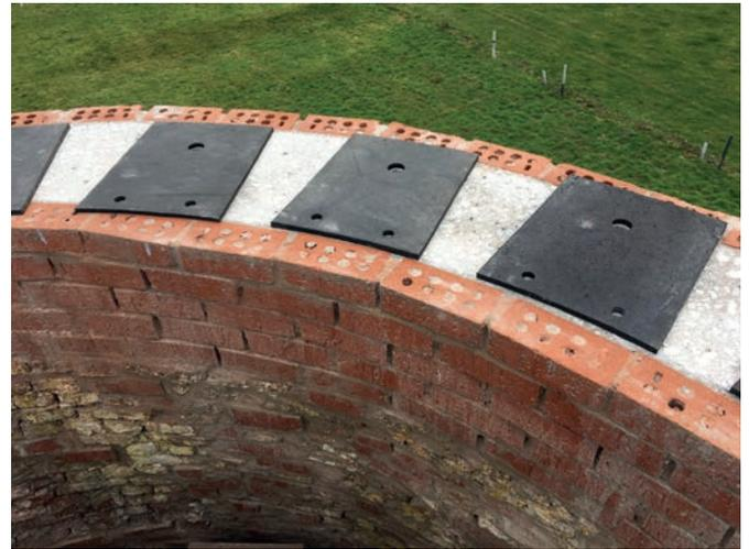
Fig. 29. Placement des feuilles de caoutchouc. Photo © F. Platbrood.
