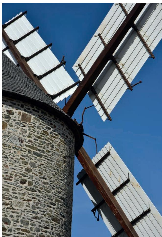
Fig. 19. Moulin à vent de Moidrey avec ses ailes système Berton déployées (détail). Baie du Mont Saint-Michel, Manche (Normandie). 1806 (restauré). Photo P. Cattelain @ Écomusée du Viroin, ULB, Treignes, 2019.
