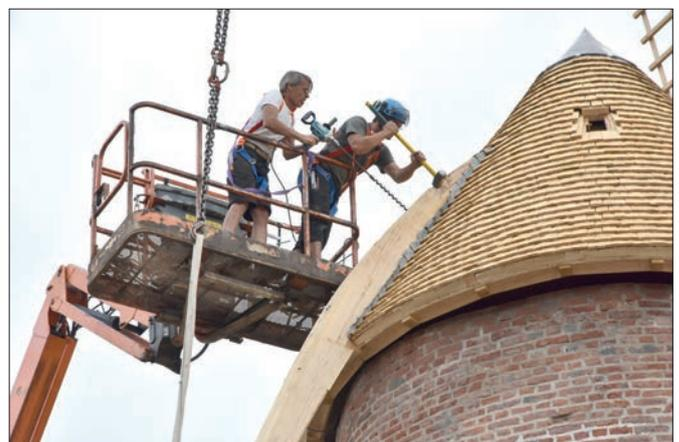
Fig. 47 à 49. Mise en place de la guivre, qui permet de diriger manuellement la coiffe, le 31 juillet 2019.
