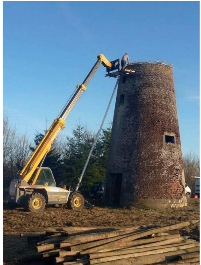
Fig. 15. Placement du toit provisoire en 2017. Photo © F. Platbrood.
