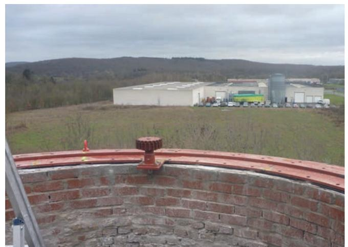
Fig. 31. Vue du chemin de roulement placé. Photo © F. Platbrood.
