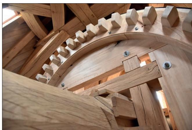
Fig. 61. Le rouet, en place sous la coiffe.
