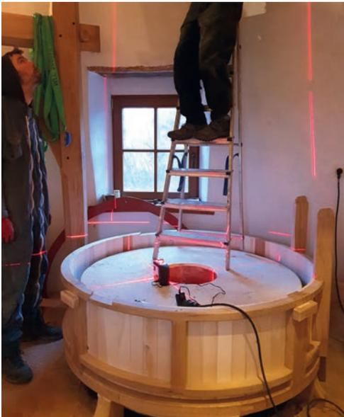
Fig. 73. Placement de la meule au laser en fonction de l'axe central, fin 2019. Photo © F. Platbrood.
