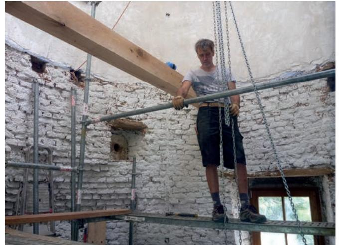
Fig. 56. Placement des solives des planchers.
