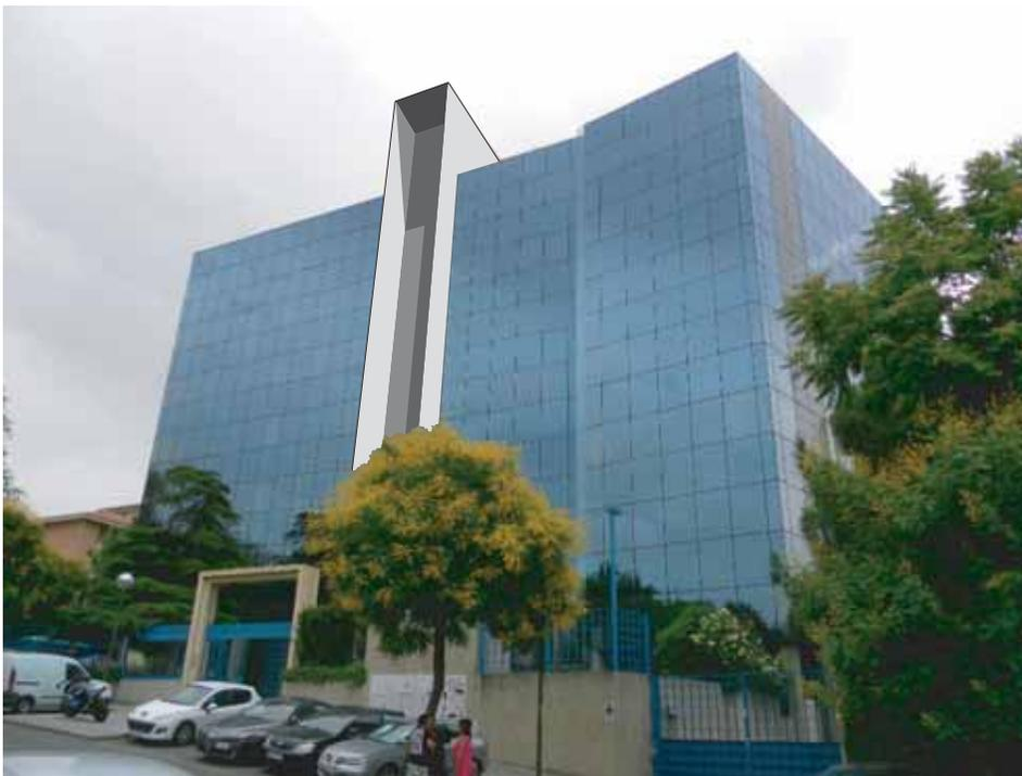
Remodelación del cuerpo frontal de la escalera principal para simplificar su sistema de ventilación, creando un volumen singular que moderniza la fachada. Cara externa de alucobond. Cara interna abocinada alucobond con cambio de color o Prodema
