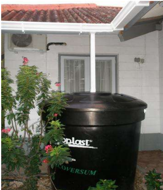
Foto 3: Dakgoot en regencontainer 71
