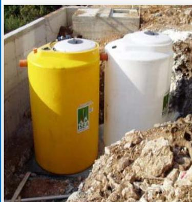
Primar. taložnica je usklađena sa zahtjevima norme BAS EN 12255-4:2004 (EN 12255-4:2002) i norme BAS EN 12566-1/A1:2005 (EN 12566-1:2000/A1:2003). Compact je usklađen sa zahtjevima normi: BAS EN 12255-6:2004 (EN 12255-6:2002); BAS EN 12566-2:2008 (EN 12566-2:2005 IDT ); BAS EN 12566-3:2008 (EN 12566-3:2005 IDT)
