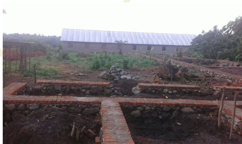
Cimientos del nuevo pabellón de secundaria del colegio de Bulongo (Al fondo el pabellón de primaria)
