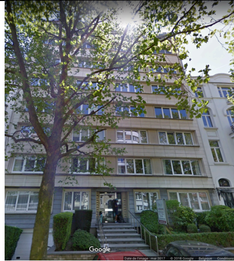
Immeuble construit dans les années 70
