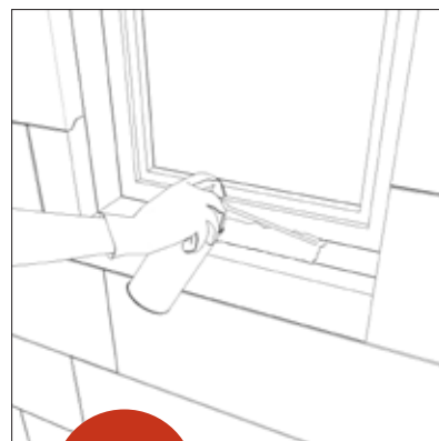
30 Applicare la colla THERMART-GLUE sul davanzale della finestra
