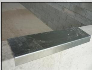
Coiffe métallique obligatoire pour clavetage des éléments préfabriqués Vstock.
