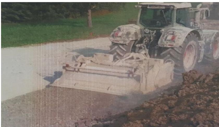
Traktor mit Kalkfräse für Bodenstabilisierung
