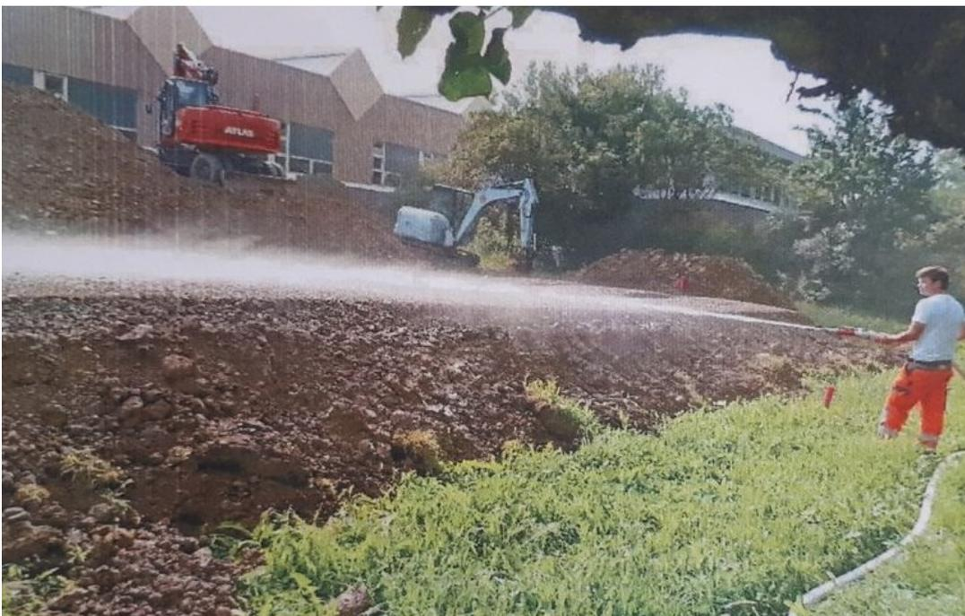
Wasseraufbringung zur Bodenstabilisierung (Reaktion Kalk mit Wasser)
