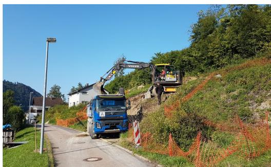
Radbagger für Baggerarbeiten aller Art, z.B. Baugrubenaushub, Kanalarbeiten und Abbrucharbeiten
