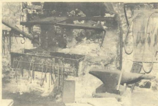
Vue intérieure, le foyer et quelques outils
