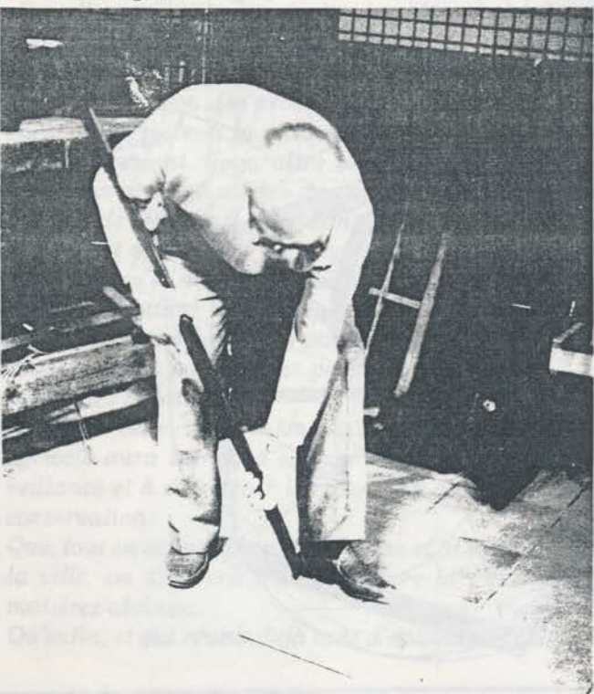
Avec la bisaigüe, côté bédane, le charpentier creuse la mortaise (fig 2).
