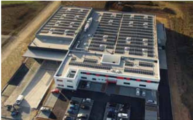
Der Neubau der PAWI Packaging GmbH in Singen wurde innerhalb eines Jahres realisiert. Eine Kollektorfläche von 2.300 m<sup>2</sup> auf dem Dach leistet eine Energieproduktion von 325.000 kWh pro Jahr. Das sind über 60 Prozent des Eigenbedarfs.
