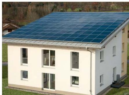
Vitovolt Photovoltaik-Module von Viessmann liefern auch noch bei teilweise beschatteten Flächen einen hohen Ertrag zur Stromerzeugung.
