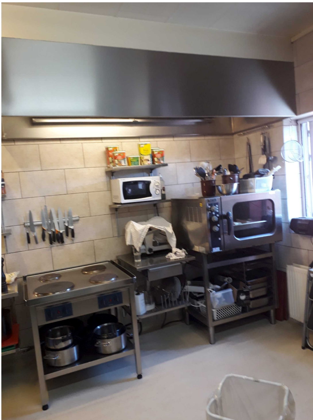
Billede 1: Procesventilation på kogeplader og ovn
