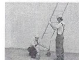
27. Inserire le ruote sulle fiancate da due metri con e senza scala
