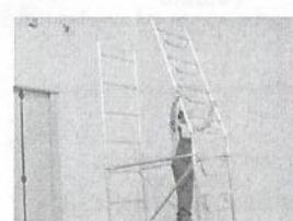
39. Inserire la fiancata senza scala e la fiancata con scala della seconda campata.
