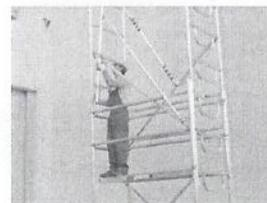
21. Sollevare ed agganciare i montanti del parapetto di montaggio telescopico in modo da realizzare la protezione anticaduta ad 1 metro dal piano di calpestio.
