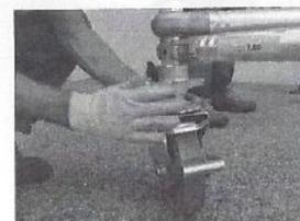
34. Agire sulla ghiera di regolazione altezza ruota per rendere piana la base della torre mobile.
