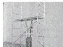
13. Collocare il piano di lavoro con botola sul secondo traverso della seconda campata.
