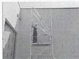
50. Sollevare ed agganciare i montanti del parapetto di montaggio telescopico in modo da realizzare la protezione anticaduta ad 1 metro dal piano di calpestio che si andrà a montare successivamente.
