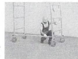
28. Agganciare un corrente di protezione (colore giallo) alla base delle fiancate, collocandolo appena sopra alla boccola inferiore delle fiancate stesse.
