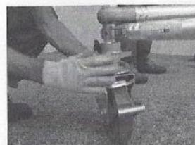
7. Agire sulla ghiera di regolazione altezza ruota per rendere piana la base della torre mobile.
