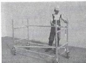
5. Agganciare un corrente di protezione (colore giallo) provvisorio sopra il secondo traverso delle due fiancate di base da metro, in modo da rendere stabili le fiancate stesse.
