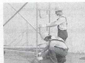
33. Controllare la planarità della torre tramite livella, e se necessario...
