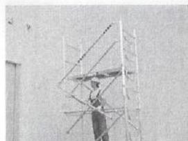
44. Svincolare il parapetto di montaggio telescopico agendo sul cricchetto di bloccaggio ed estenderlo.
