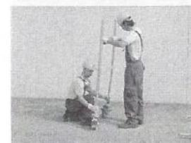
1. Inserire le ruote sulle fiancate di base da metro con e senza scala
