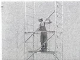
41. Agganciare le diagonali di facciata per stabilizzare le fiancate del secondo livello in modo che il gancio superiore della diagonale sia a 2 m dal piano di calpestio sul quale staziona l'operatore.
