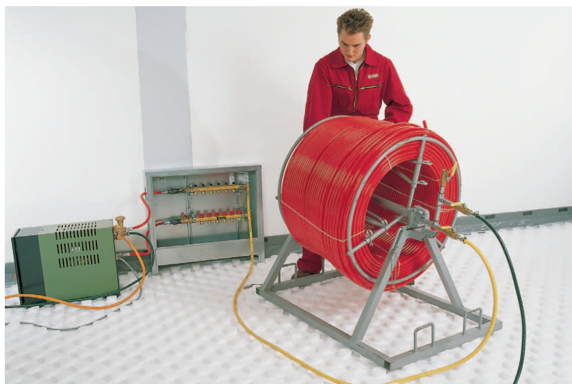
2.1 Abb. 51: Einsatz der REHAU-Warmabrollvorrichtung
