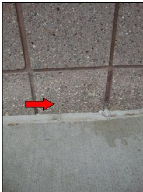
Spalling
