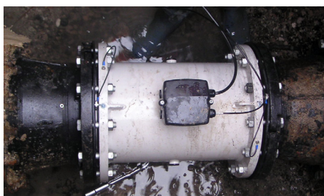
Forsyning og indvinding: MAG 8000 begrænser behovet for vedligehold og finder tidligt eventuelle lækager.
