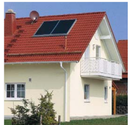
Bild 17: Vitosol 100, Typ 5DI Großflächen-Flachkollektor für Dachintegration auf Schrägdächern mit Dachpfannen-Eindeckung
