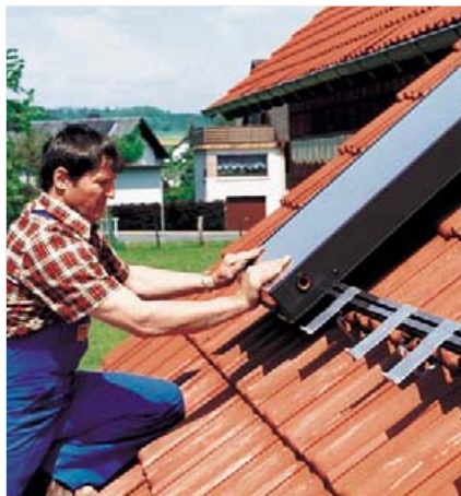
Bild 35: Einfache Dachmontage mit dem mitgelieferten Befestigungsmaterial
