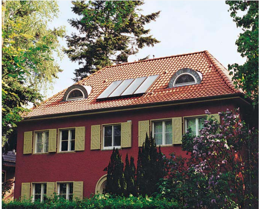
Bild 38: Zweifamilienhaus mit Vitosol 100 Flachkollektoren
