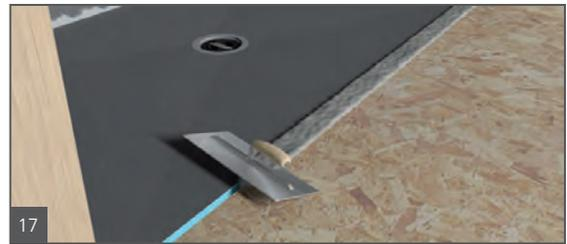
Appliquer du ciment-colle sur le sous-plancher en bois jusqu'à atteindre 100 mm (4 po) à l'intérieur de la base du receveur de douche wedi Fundo Ligno. Remplir la rainure wedi Fundo Ligno avec du ciment-colle ou avec une bande de panneau de construction wedi scellée et appliquer du ciment-colle dans l'angle inférieur des panneaux muraux wedi, à gauche et à droite de toute entrée, à l'aide d'une truelle dentelée de 6 mm x 6 mm (1/4 po x 1/4 po).
