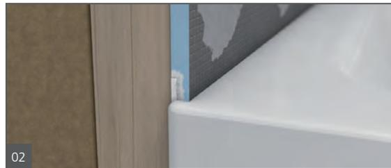
Mesurer et couper le panneau de construction wedi pour l'adapter aux montants espacés de 406 mm (16 po) de centre à centre (bois ou métal). Pratiquer une rainure sur tous les panneaux, s'ils sont installés autour du périmètre d'une baignoire à rebord, pour intégrer le rebord et achever un mur vertical avec des angles droits et ajustés.
