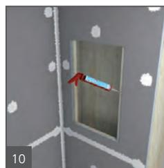
Les niches wedi sont installées dans une découpe pratiquée dans le mur wedi et fixées directement par leurs brides au milieu des montants espacés de 406 mm (16 po) centre à centre. Du produit d'étanchéité wedi est déposé le long du contact entre le mur et la niche.
