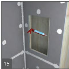
Les niches wedi sont installées dans une découpe pratiquée dans le mur wedi et fixées directement par leurs brides au milieu des montants espacés de 406 mm (16 po) centre à centre. Du produit d'étanchéité wedi est déposé le long du contact entre le mur et la niche.
