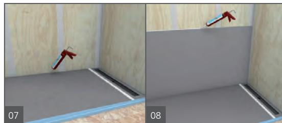
Tirer un cordon de 13 mm (1/2 po) de produit d'étanchéité wedi en suivant les rainures du périmètre extérieur de la base mais seulement sur les zones dans lesquelles un panneau de construction wedi peut être posé immédiatement dans le produit d'étanchéité frais.
