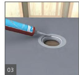
Tirer un cordon continu de 6 mm (1/4 po) de produit d'étanchéité wedi le long du profil rainuré supérieur de la vanne wedi Fundo.
