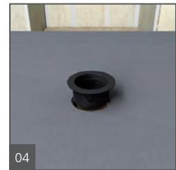
Plonger fermement le corps de l'écoulement dans le produit d'étanchéité.
