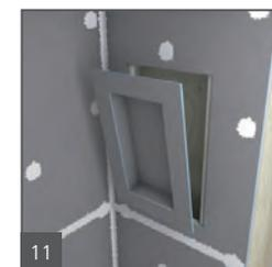
Deux fixations sont placées de chaque côté de la niche pour créer une transition affleurante avec les panneaux muraux. Un cordon supplémentaire de 13 mm (1/2 po) de produit d'étanchéité est étalé sur les fixations et les joints.
