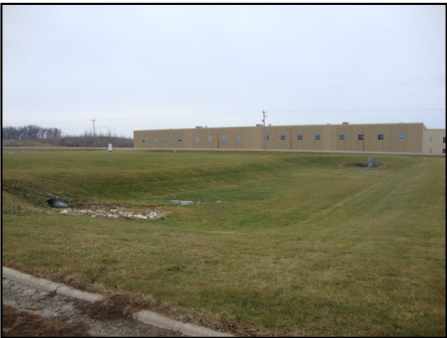
63 : Site - Retention Pond 1
