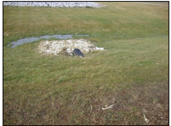
70 : Site - Stormwater Discharge 2
