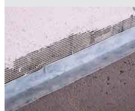
Nastro autoadesivo elastico a base butilica, rivestito da un tessuto non tessuto in polipropilene idrorepellente appositamente studiato per l'impermeabilizzazione elastica dei giunti e degli angoli di balconi, terrazze, pavimenti prima della posa della guaina liquida.
