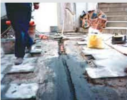
Malta antiritiro a presa normale con elevata resistenza chimico-meccanica, specifica per ripristini e riparazioni su calcestruzzo, intonaci e murature cementizie. La sua particolare miscela di cementi alluminosi, inerti selezionati e ricercati additivi assicura un'ottima adesione ai supporti con elevata tixotropicità e impermeabilità.
