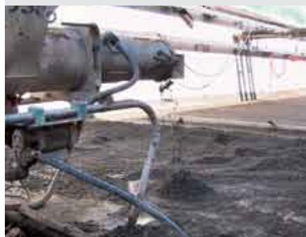
Betonino premiscelato fibrorinforzato da utilizzarsi per la messa in opera di massetti interni a rapida asciugatura (umidità residua dopo 3 giorni inferiore al 2%) e rifinibili entro la prima settimana dall'applicazione con qualsiasi tipo di pavimentazione (piastrelle di ceramica o cotto, legno, moquette, linoleum).
