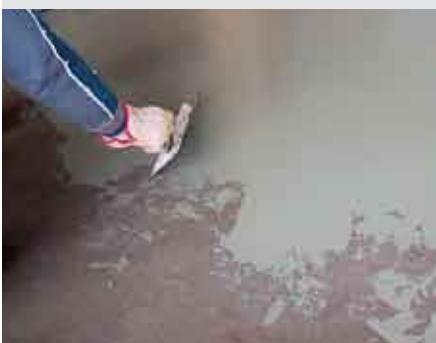
Malta speciale bicomponente elastomerica adatta per rivestimenti e impermeabilizzazioni flessibili di superfici in calcestruzzo, intonaci e massetti cementizi. Rain Plasto Flex è composto da una miscela di cementi speciali, inerti selezionati e additivi che vengono modificati da una resina polimerica flessibilizzante per formare un impasto scorrevole e di grande adesione, applicabile anche in verticale. Rain Plasto Flex è adatto per:
