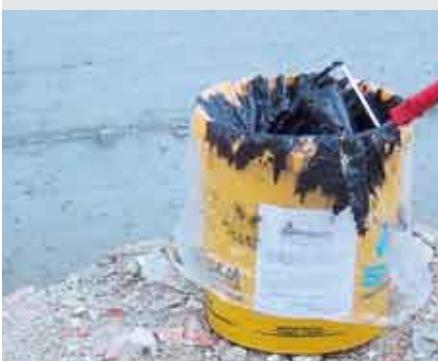
Guaina liquida impermeabilizzante di buona elasticità. Rain Elastic Color E è una guaina economica semipedonabile: si usa per l'impermeabilizzazione e la protezione di superfici in calcestruzzo, di coperture in lastre di cemento amianto, in tegole di cemento, terrazze in calcestruzzo, per risanare i vecchi manti bituminosi, per pitturare e impermeabilizzare facciate in cemento, pannelli prefabbricati, per superfici metalliche o ferrose.
