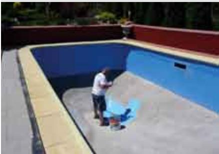
Membrana liquida elastomerica di alta qualità a base di resine polimeriche in emulsione acquosa. Il prodotto è una pasta monocomponente impermeabilizzante e protettiva che grazie alla sua tissotropia può essere applicato semplicemente su superfici orizzontali, inclinate e verticali.
