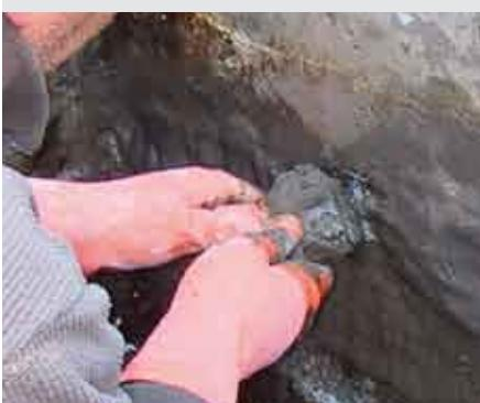
Cemento idraulico impermeabilizzante a presa ultrarapida idoneo per bloccare istantaneamente le infiltrazioni dirette e localizzate di acqua nelle murature anche in forte pressione. Rain Blok è stato studiato appositamente per tutti gli interventi di preparazione all'impermeabilizzazione in contropiatta di scantinati, muri controterra, fosse ascensore, serbatoi, pozzetti, gallerie in presenza di umidità prima del trattamento con cemento osmotico Rain Base.
