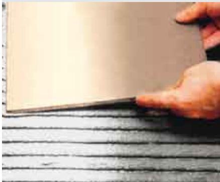
Adesivo in polvere universale a base cementizia a media flessibilità per pavimenti e rivestimenti, indicato per uso interno ed esterno per l'incollaggio di mosaici, piastrelle, ceramiche di ogni tipo, a pavimento o a parete, gres, clinker. Rain Kol 500-550 può essere additivato con il lattice Flexo 033 per ottenere una maggiore adesività, impermeabilità ed elasticità; si impasta con acqua pulita e si applica manualmente con spatola dentata in acciaio su sottosuoli puliti e solidi.
