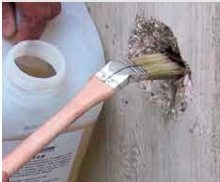
Convertitore di ruggine liquido formulato per l'applicazione sui ferri di armatura del cls, ferro e superfici metalliche ossidabili in genere. Esso converte la ruggine esistente e previene la possibile corrosione. Sulle superfici trattate con Isolfer è possibile procedere direttamente con le applicazioni successive richieste.
