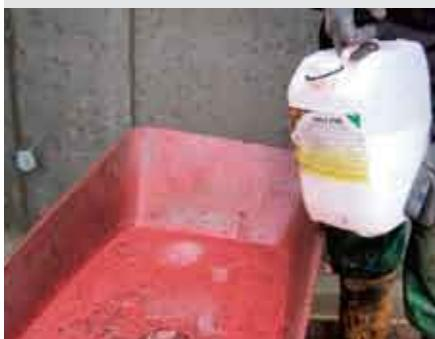
Lattice additivo adesivo e plastificante, idoneo per la preparazione di malte o boiacche; rende ogni impasto impermeabile all'acqua e in particolare ne aumenta il modulo di elasticità, la flessibilità e l'adesione.
