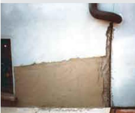
Malta fine rasante a base di leganti idraulici, sabbie silicee ed additivi specifici studiata appositamente per eseguire rasature su calcestruzzi o vecchi intonaci cementizi, su superfici leggermente irregolari sia all'esterno che all'interno di edifici o come finitura delle malte Rain Presa.
