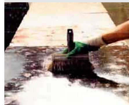
Disarmante pronto all'uso studiato per favorire il distacco dalle casseforme metalliche e/o plastiche, di manufatti in calcestruzzo, precompresso e non, sia a maturazione naturale che a vapore. E' costituito da una miscela selezionata di sostanze sintetiche e di additivi anticorrosivi.
