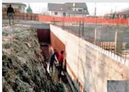
Cemento osmotico impermeabilizzante specifico per supporti esterni. Rain Scudo Rosso è un composto in polvere cementizio con un elevato potere cristallizzante e stagnante, studiato appositamente per impermeabilizzare muri di fondazioni controterra e supporti in calcestruzzo interrati.
