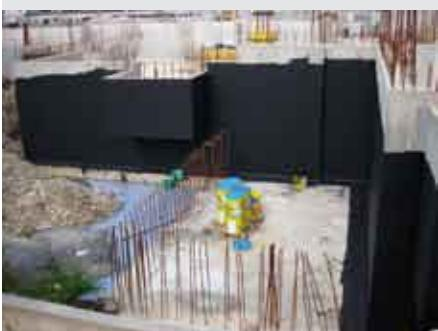
Guaina liquida impermeabilizzante elastomerica all'acqua: è resistente al caldo e al freddo e all'azione dei raggi ultravioletti.
