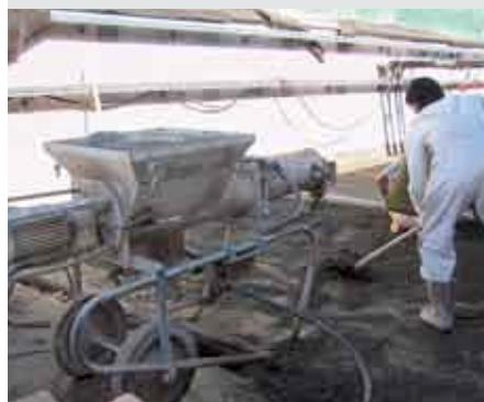
Legante idraulico speciale, da utilizzarsi per la messa in opera di massetti con indurimento in circa 24 ore ed asciugamento veloce (circa 7 giorni).
