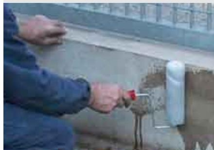
Idrorepellente siliconico in emulsione acquosa per murature pronto all'uso. Il prodotto è utilizzabile per l'idrofobizzazione di materiali edili assorbenti scarsamente alcalini quali murature, mattoni e mattoni faccia vista, cemento espanso, materiali ceramici grezzi, materiali lapidei, tegole, vasi in cotto, etc. Rain Via Sal si applica tal quale a pennello, rullo o spruzzo sul supporto da trattare.
