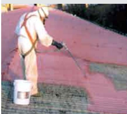
Incapsulante temporaneo a base di resine speciali idoneo per la bonifica e la rimozione dei manufatti in cemento amianto. Rain Fix si presenta come un lattice di resine fortemente penetrante e aggrappante, specifico per fissare nelle superfici in cemento amianto le eventuali particelle e fibre libere, facendole così aderire al substrato del manufatto.
