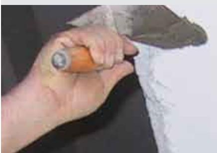
Malta antiritiro fibrorinforzata tixotropica a presa normale, specifica per ripristini e riparazioni su calcestruzzo e supporti cementizi come cornicioni, spigoli, balconi dove è necessario intervenire in sospensione. La sua particolare miscela di cementi alluminosi, inerti selezionati, fibre e ricercati additivi assicurano un'ottima adesione ai supporti con elevata tixotropicità.
