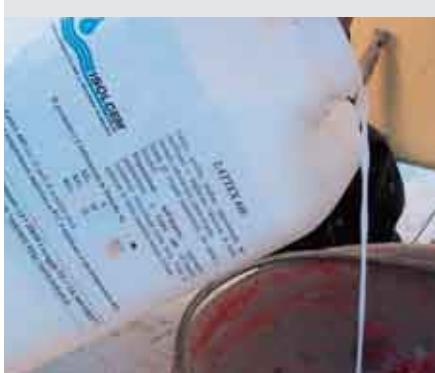
Lattice aggrappante adesivo e plastificante, idoneo sia per la preparazione di malte e boiacche sia come ponte di adesione nelle riprese di getto; conferisce all'impasto un più rapido tempo di presa e un assorbimento d'acqua minore, un miglioramento delle caratteristiche fisico-chimiche ed un aumento dell'adesività sulle riprese di getto.
