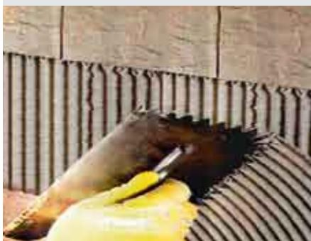
Adesivo in polvere universale a base cementizia per pavimenti e rivestimenti tradizionali, indicato per uso interno per l'incollaggio rigido di mosaici, piastrelle ceramiche di ogni tipo, a pavimento o a parete.
