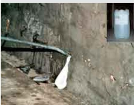
Impregnante idrofobizzante silanico a base solvente inodore studiato specificatamente per creare barriere chimiche contro l'umidità ascendente nelle murature. Rain Bar Injection è un prodotto pronto all'uso da iniettare a bassa pressione sulle murature ammalorate il quale in presenza di umidità reagisce formando una barriera invisibile altamente idrofoba.
