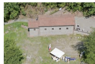
La centrale di Sillico
