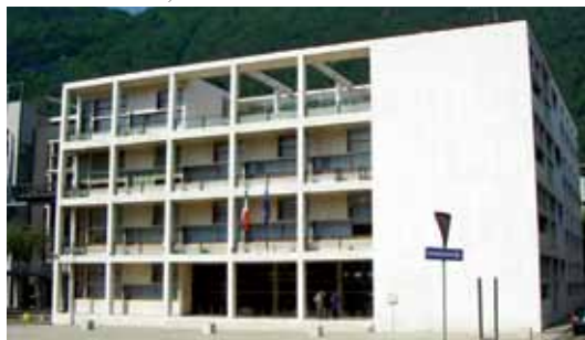
Ex Casa del Fascio, Como
